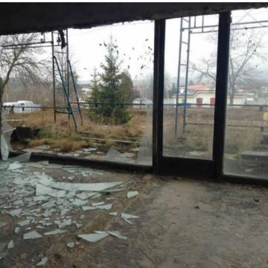
Реконструкція адмінбудівлі МАПП "Ужгород"
